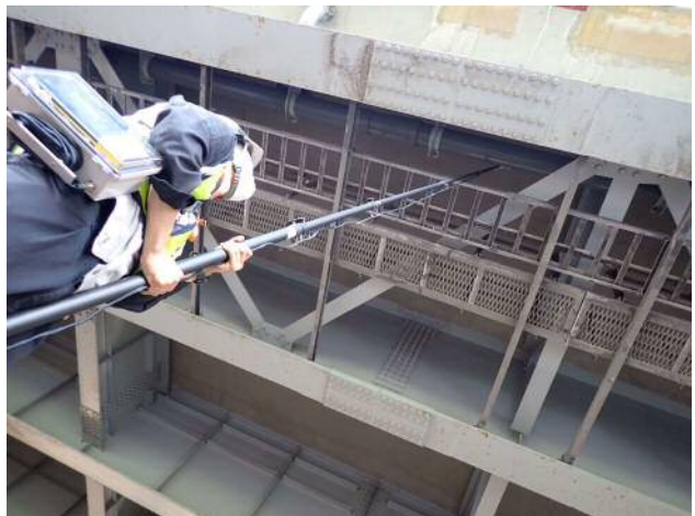
こんこんを用いた狭隘部の点検状況
