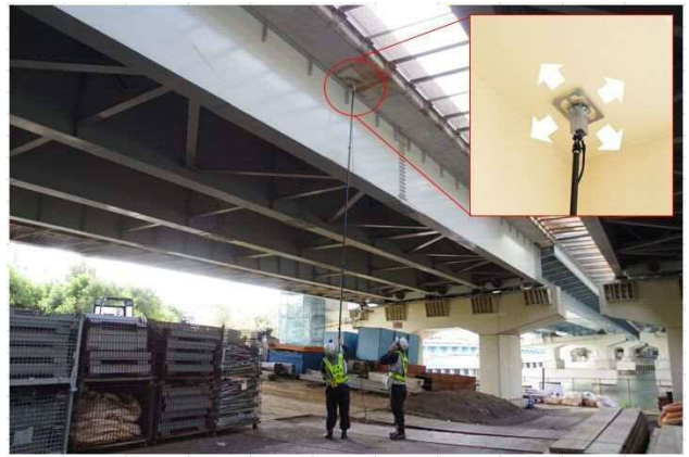
こんこんを使用した点検状況
