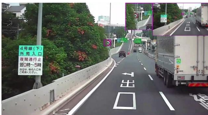
図-4 交通事故や違反を誘発する植栽などによる標識隠れ（紫色枠）
