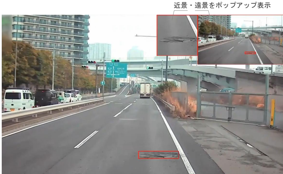
図-2 パンクや事故を誘発する舗装穴（赤色枠）
